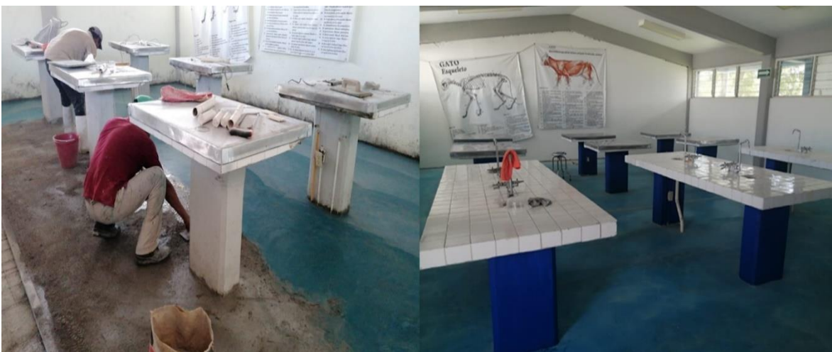
Figura 18: Restauración de pisos del laboratorio de Veterinaria “Juan Carlos Muñoz González”.
