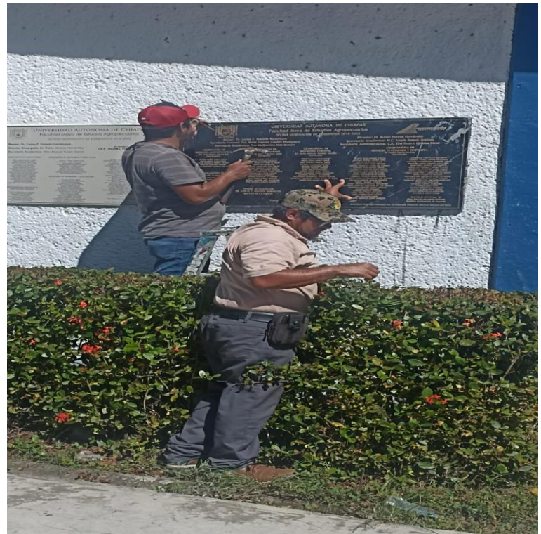
Anexo 16. Instalación de placas de egresado de las diferentes licenciaturas de la FMEA.
