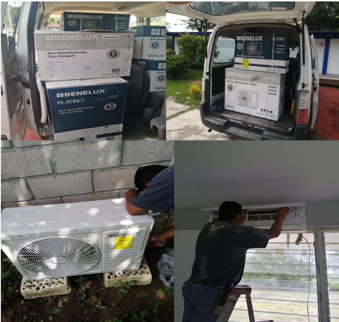
Figura 19: Mantenimiento e instalación de acondicionadores de aire de la Facultad Maya.
